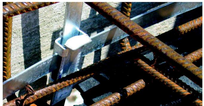
Figure 6 – Electrode de terre de fondation: point de jonction supportant le courant.
