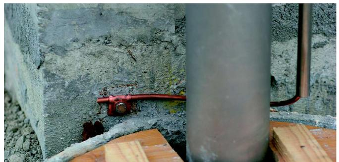
Figure 7 – Le ligne de mise à la terre ont raccordé à l'électrode de terre de fondation par l'intermédiaire de ligne de mise à la terre et point de sectionnement.
