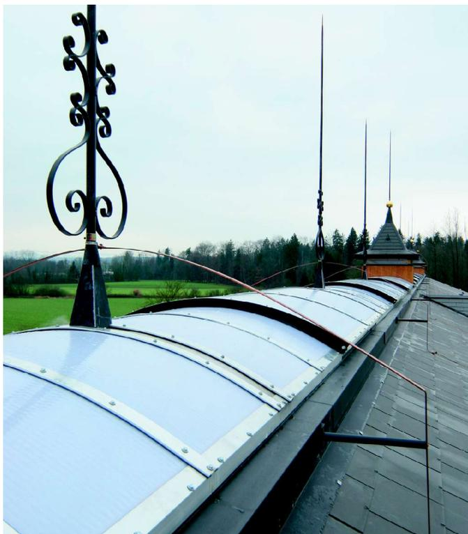
Figure 4 – Axe longitudinal du faite (coupole d'aération) avec le paratonnerre.
