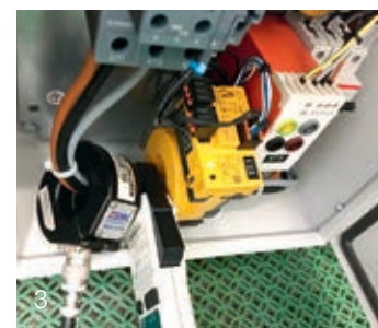
1 Wasserspiel Aquaretum beim Hafen Enge. 2 Eine der vier Schwimmereinheiten. 3 Messungen an einem Umrichter.
