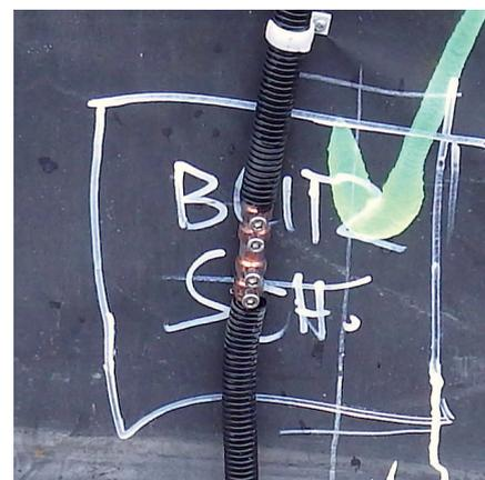
*Die von der GV verlangten zugänglichen Ableiter-Trennstellen fügen sich gut in die Fassaden- und Deckenverkleidungsstruktur ein.*
