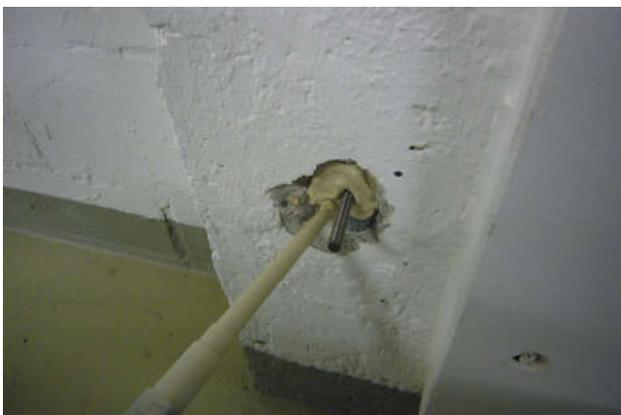
Bild 3. Freiraum mit Mörtel auffüllen
