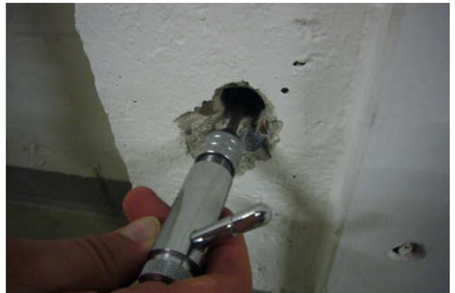
Bild 2: Gewinde in Bewehrung schneiden
