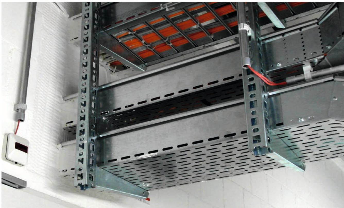
Beispiel Grossflächige Durchführung von Kabeltragsystem durch Brand-schottung (in Anlehnung an 4.4.4 Figur 24).
