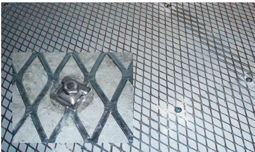
Bild 3 Grossflächig verlegte Systembezugsebene mit Stossüberlappungen in einem Rechenzentrum. Mit den eingelegten Anschlusselementen ist eine optimale Verbindung mit der Bewehrung gewährleistet.
