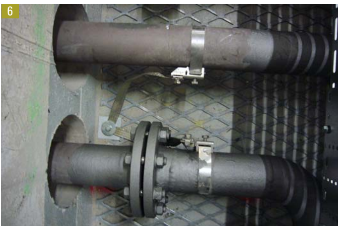
Anschlussbeispiel HLSK-Leitungen mit flexiblem Band an die SRPP.
